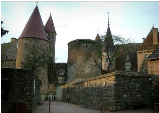
Patrimonio dello stato
